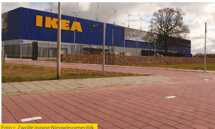
Foto 1: Zwolle ingang Nieuwleusenerdijk
